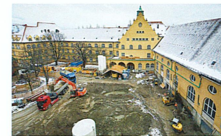
Baustelle im Februar 2019
